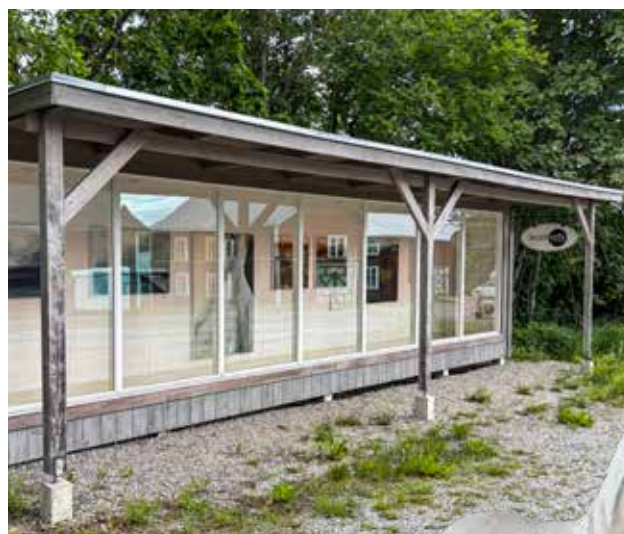
Galleri Stoorverk har drive-in.
